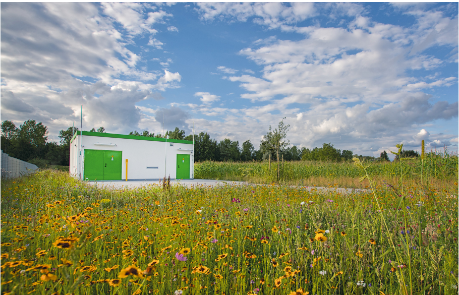
Grüner Wasserstoff soll unter anderem Erdgas (hier eine Gasdruckregelstation in Au am Rhein) ersetzen
