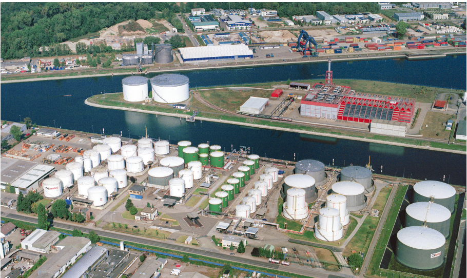
Das Großtanklager der Mabanft-Tochter Oiltanking Deutschland in den Karlsruher Rheinhäfen
